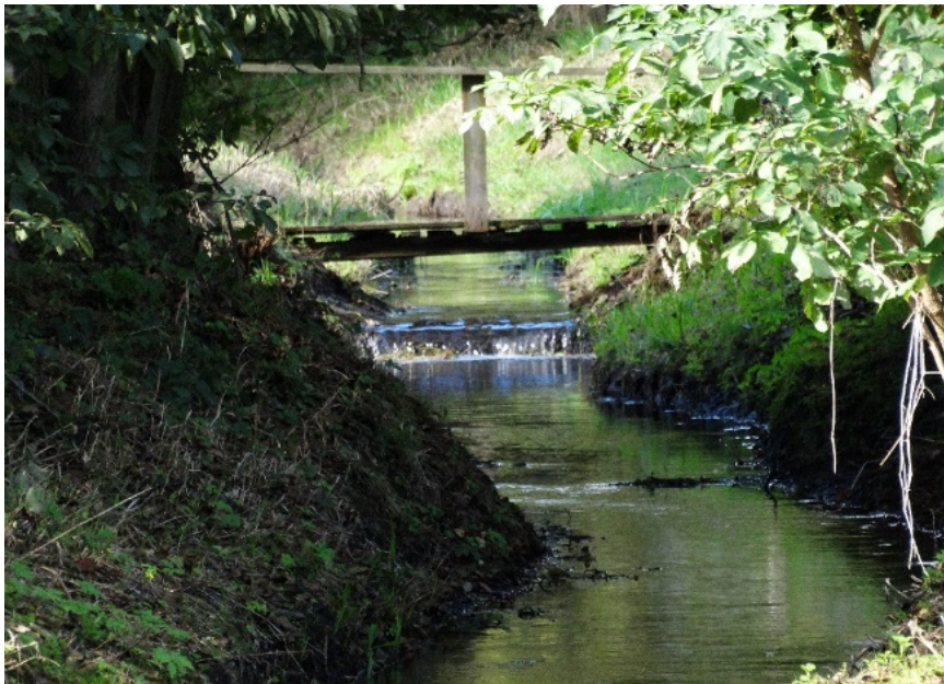
Fot.11 Betonowy próg na Moskorzynie Wykonał: Dawid Wasylik
