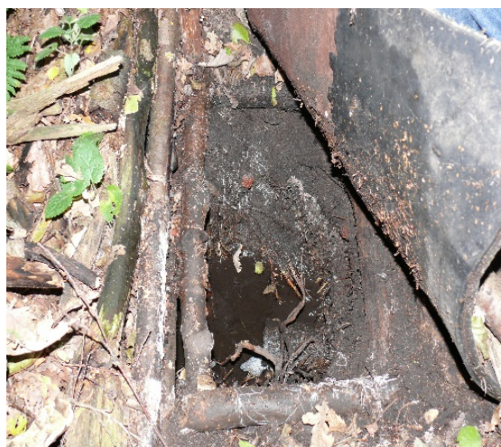
Fot. 4 Pobór wody Moskorzynki dla stawu hodowlanego Wykonał: Dawid Wasylik
